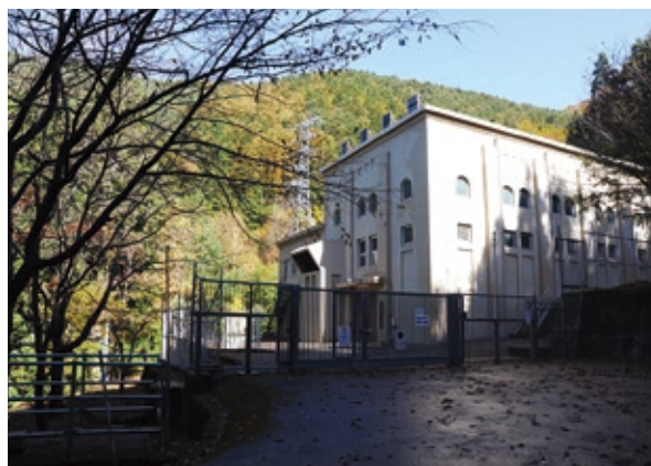
平穏第一発電所（志賀高原十二沢）
