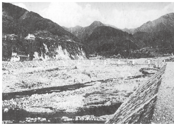
夜間瀬川1号堰堤 昭和8年 農振土木事業 横湯川・ 角間川合流地点
