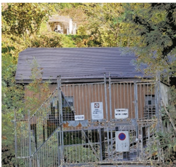
藤平第二発電所（奥に送水管が見える）
