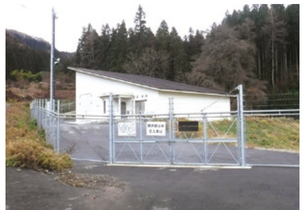
南部浄水場（上が旧、下が現）
