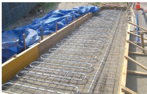
ロードヒーティング(鈴虫坂) 排湯管の設置
