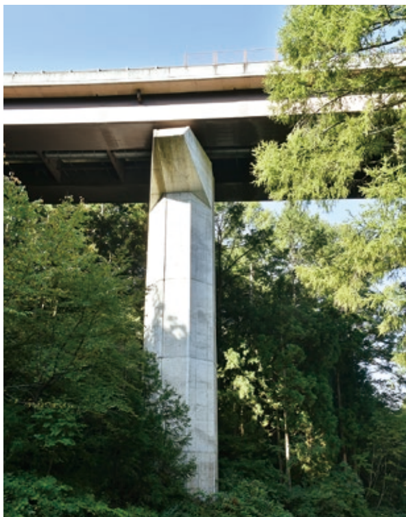
十二沢の橋梁
