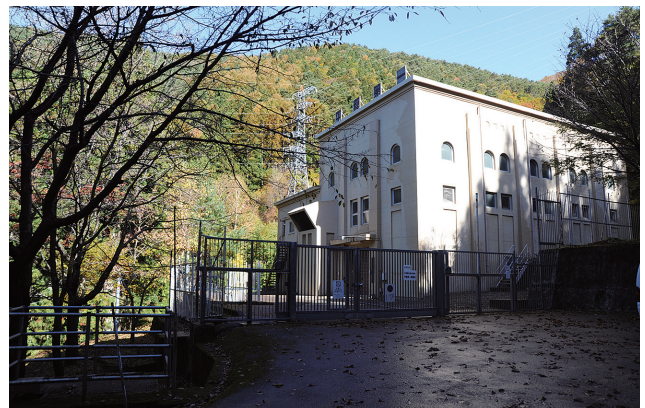
平穏第一発電所(志賀高原十二沢)
